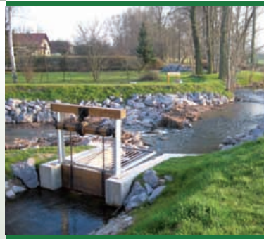
Neubau einer Sohlgleite mit Abzweig zum Mühlgraben (Flurbereinigungsverfahren Laucha, 2006)
