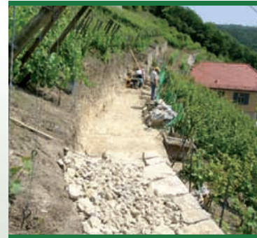
Sanierung des historischen Terrassenweinberges „Kaatschener Dachsberg“ (2003)
