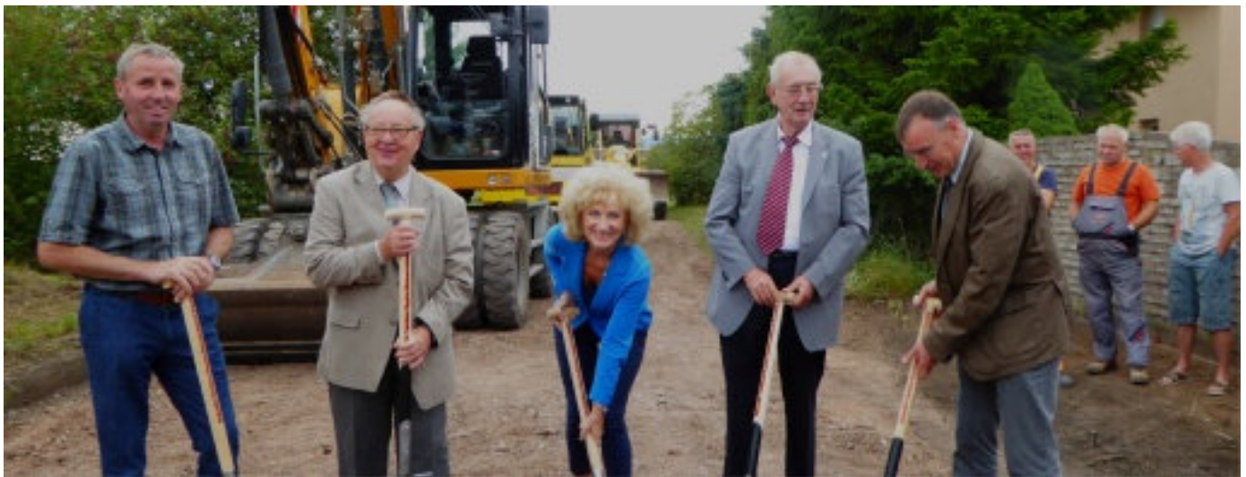
Der Spatenstich zwischen Görzbach und Auleben
