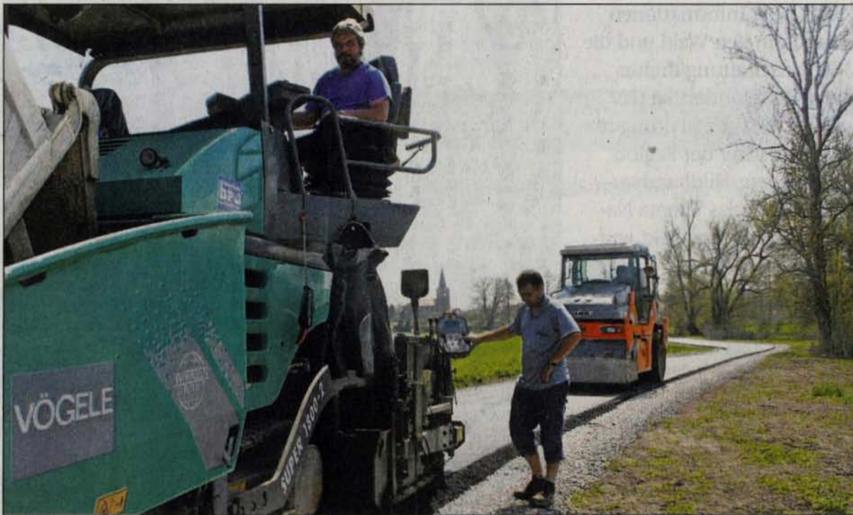
Am Donnerstag haben Arbeiter der Hildburghäuser Baugesellschaft begonnen, die Asphaltsschicht aufzuziehen. Etwa fünf Tage wird es dauern, bis der etwa 3,2 Kilometer lange Radweg in Schwarz gehüllt ist. Fotos: K. Wollschläger
