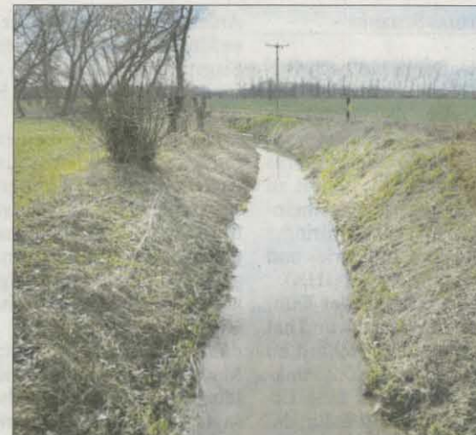
Die Flutmulde nördlich von Herbsleben nimmt überschüssiges Wasser aus der Unstrut auf. Auf dem Damm des Überlaufkanals soll ein ländlicher Weg entstehen. Foto: Jens König
