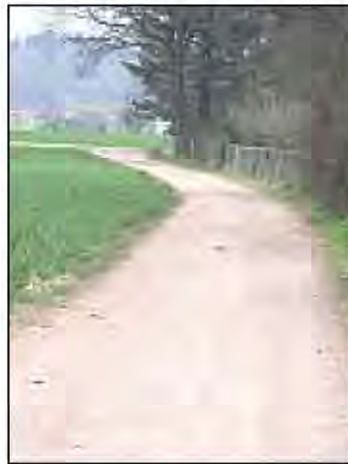
Für 1,25 Millionen Euro wurden 14,9 Kilometer Wege erneuert.
